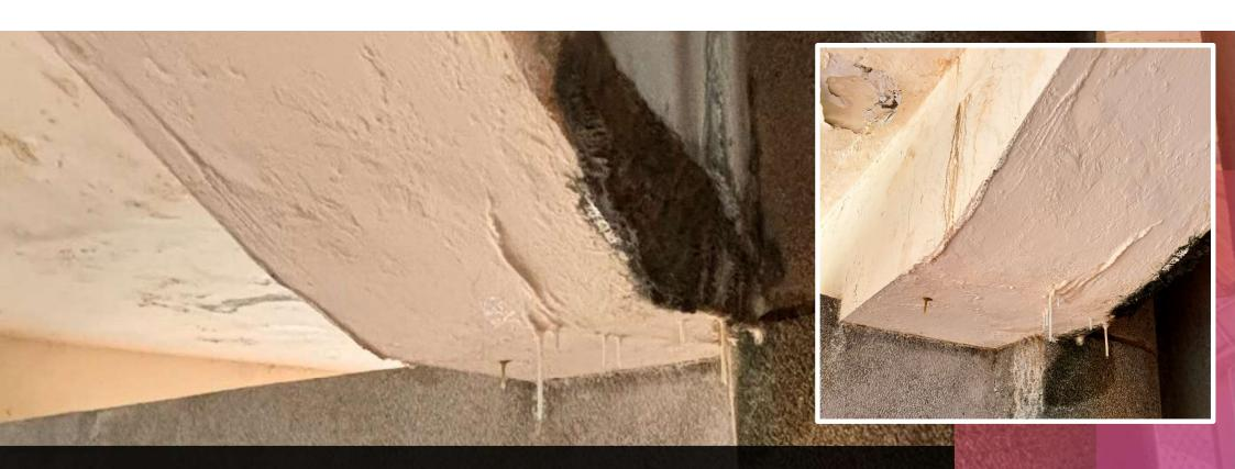
二樓橋體上方靠牆樑轉折處外側有劣痕、滲水產生白華,並 略帶銹水。 一樓橋體上方轉振外側有 轉據外側有 等源、滲水產 生白華,並略 帶銹水。
